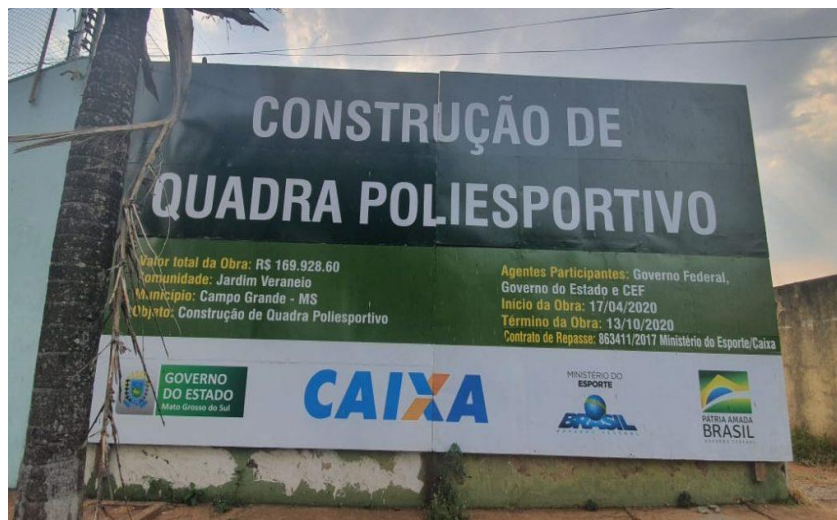
Figura 14 - Local de construção da quadra poliesportiva.
