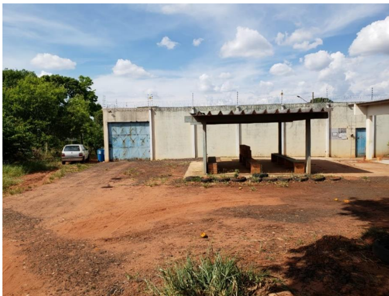
Figura 06 – Portões de entrada e local de espera dos visitantes.
