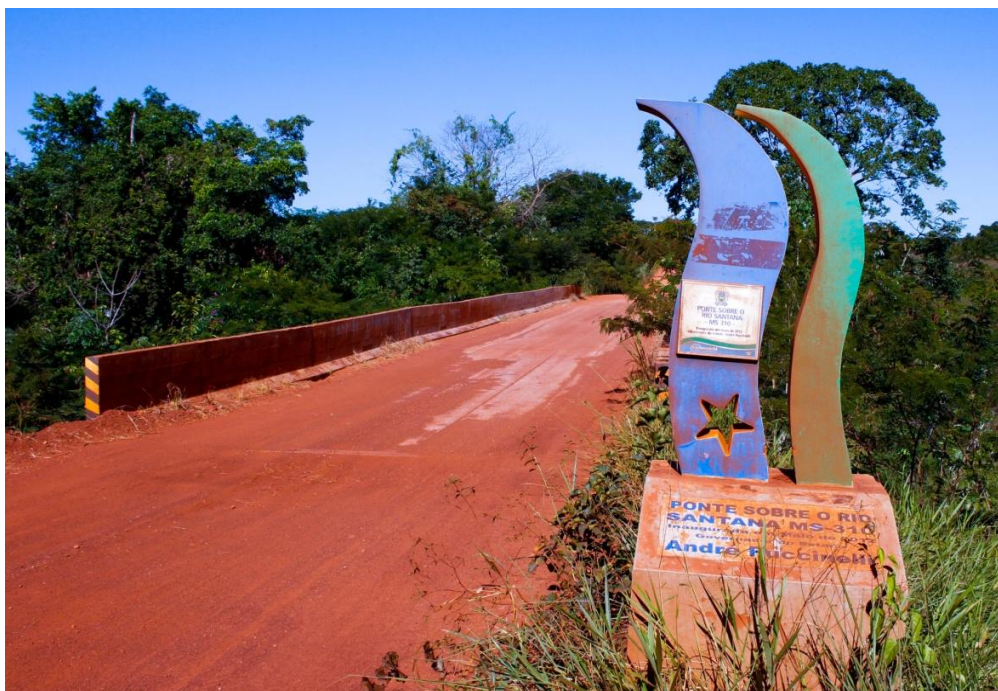
Figura 35 – Ponte sobre o rio Santana MS-310
