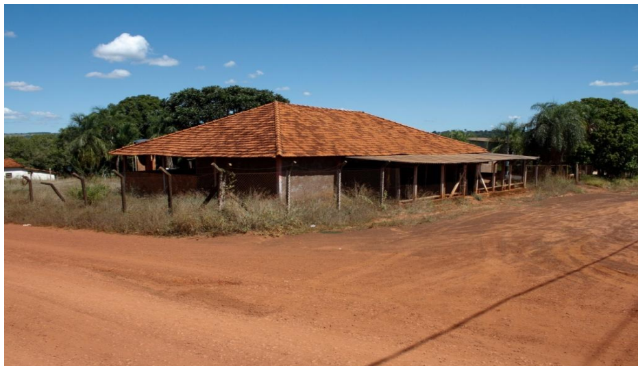
Figura 48– Barracão do Centro Rural Tamandaré
