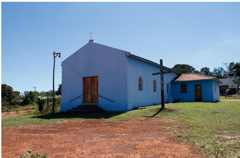
Figura 46 – Capela Nossa Senhora Aparecida, construída no ano de 1982
